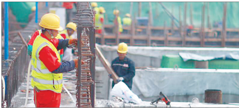
工人加紧施工
