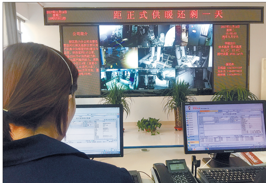
新区热力分公司客服调度室的大屏幕上显示对供热设备的监控画面
