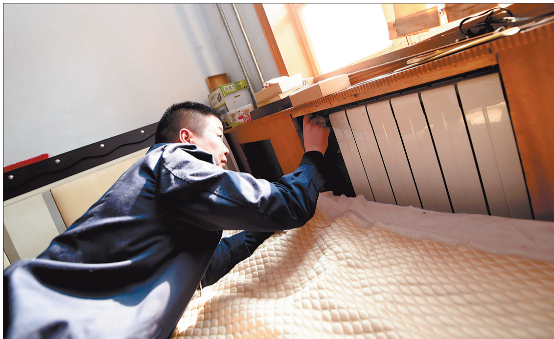
热力公司工作人员上门为用户调试暖气
