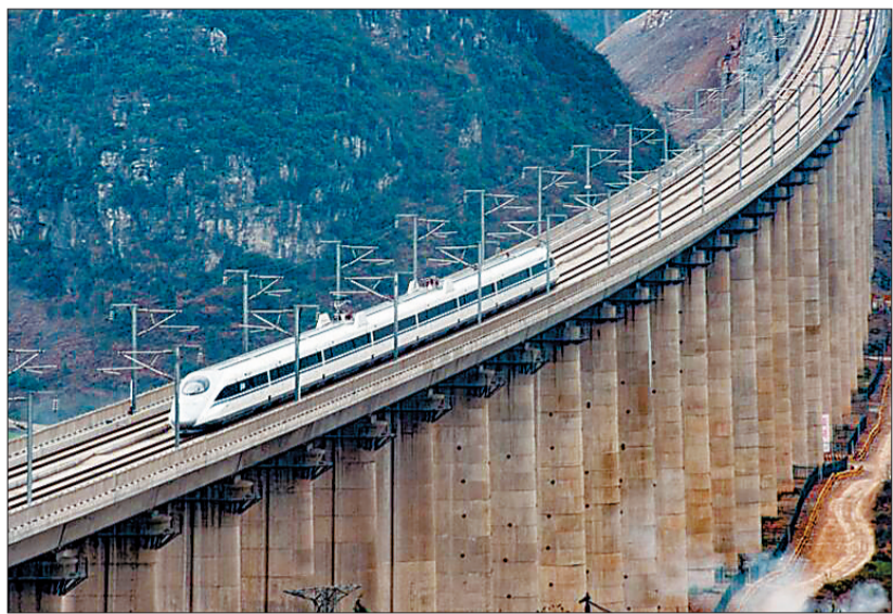
2016年12月28日,由昆明开往贵阳的G4136次列车经过贵州省安顺市境内的水桶木寨特大桥 (资料图片)
