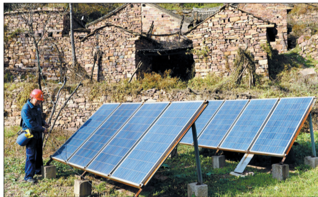
查看光伏发电设备
