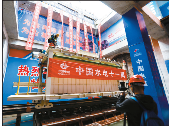
组件顺利下井
