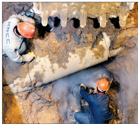
维修人员抢修热力管道
