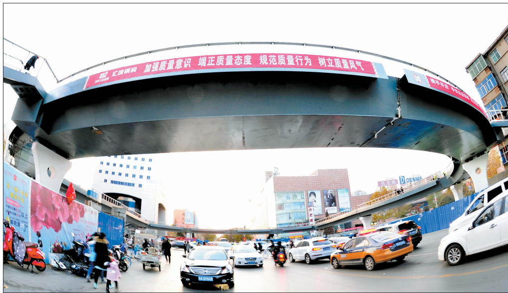
正在施工的环形过街天桥
