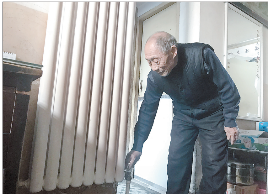
陈敬之在打开家里的燃气壁挂炉
