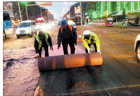
交警和施工人员一起铺毛毡 (受访者供图)
