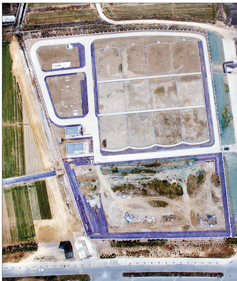
记者航拍的白马寺镇污水处理厂
