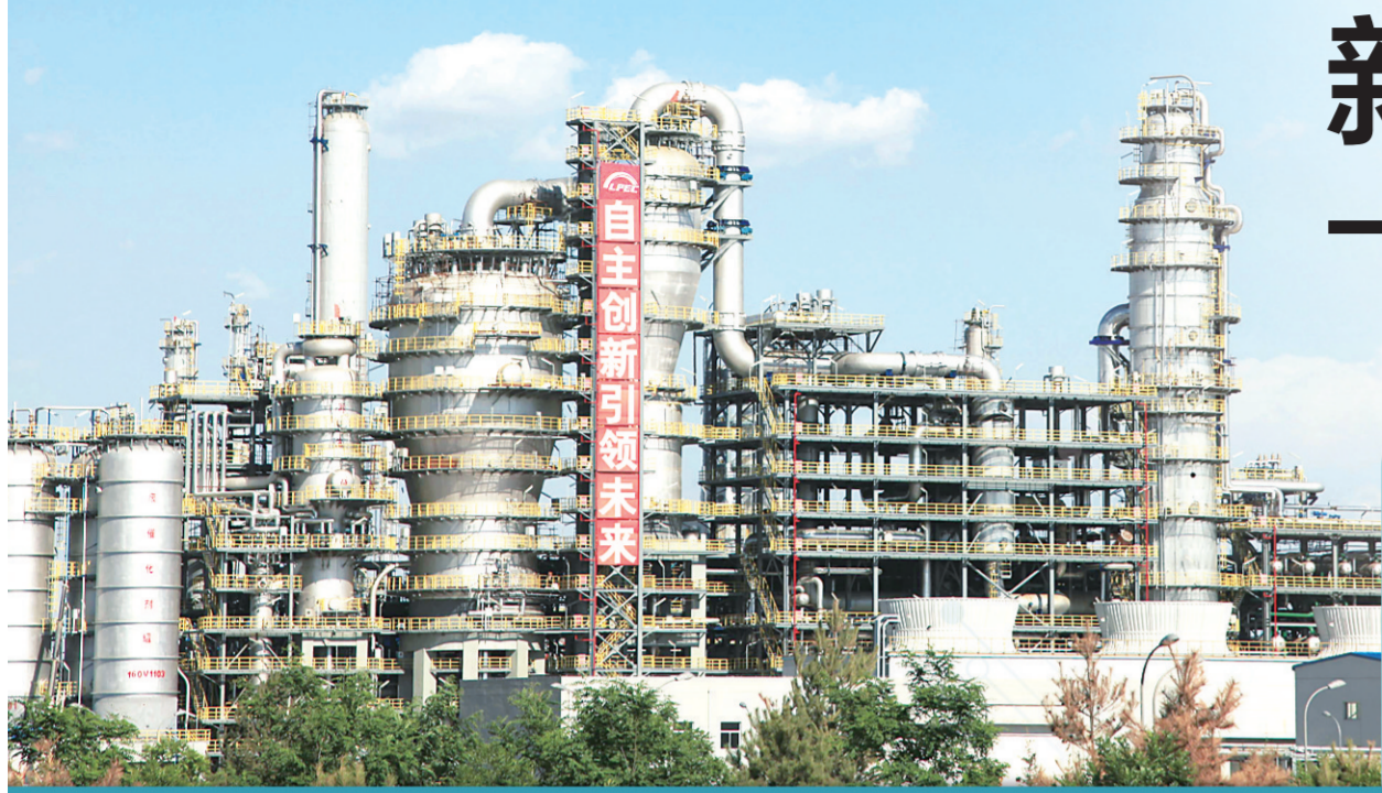
甲醇制烯烃装置 (中石化洛阳工程有限公司供图)
