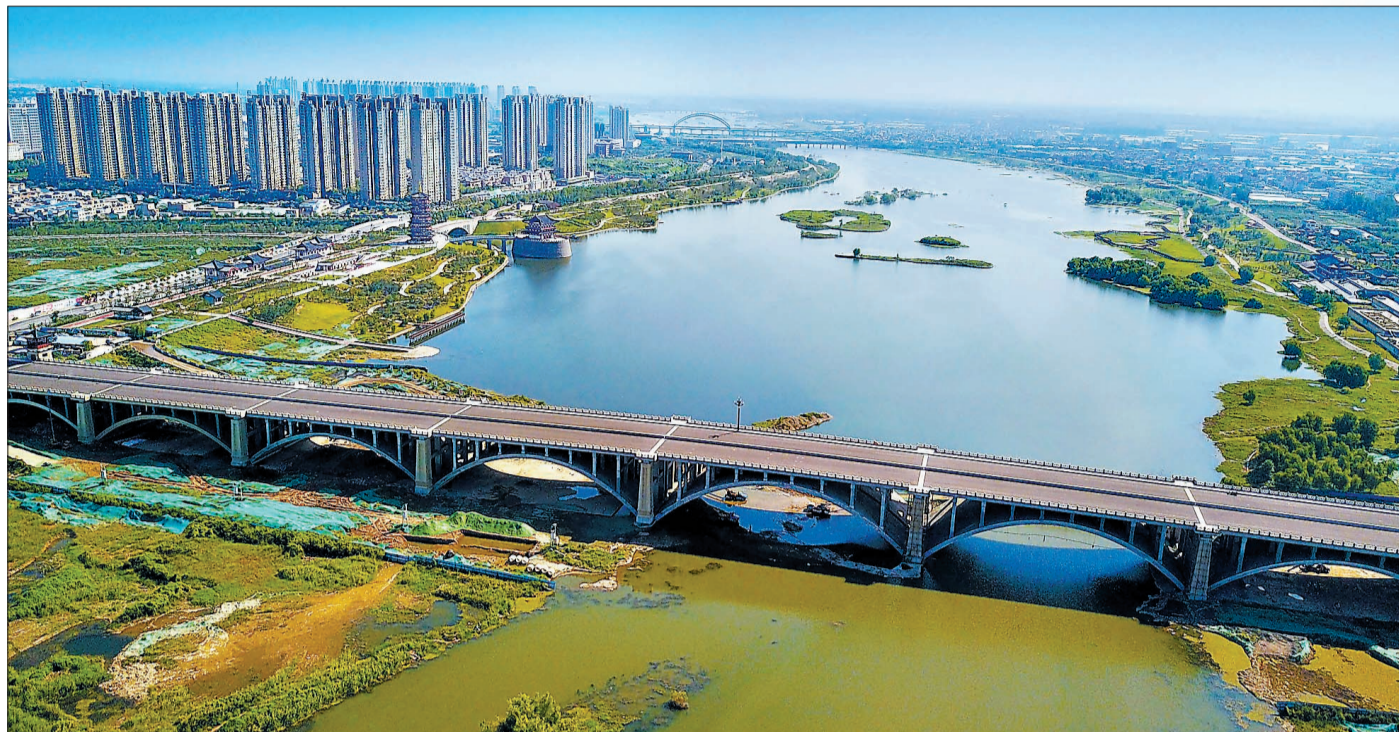
新街跨洛河大桥
