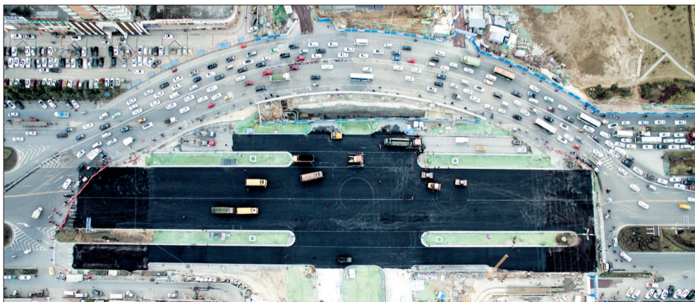
路面沥青摊铺在加紧施工
