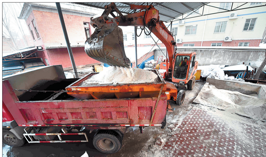
挖掘机正在往撒布机里装融雪剂 记者 张怡熙 摄
