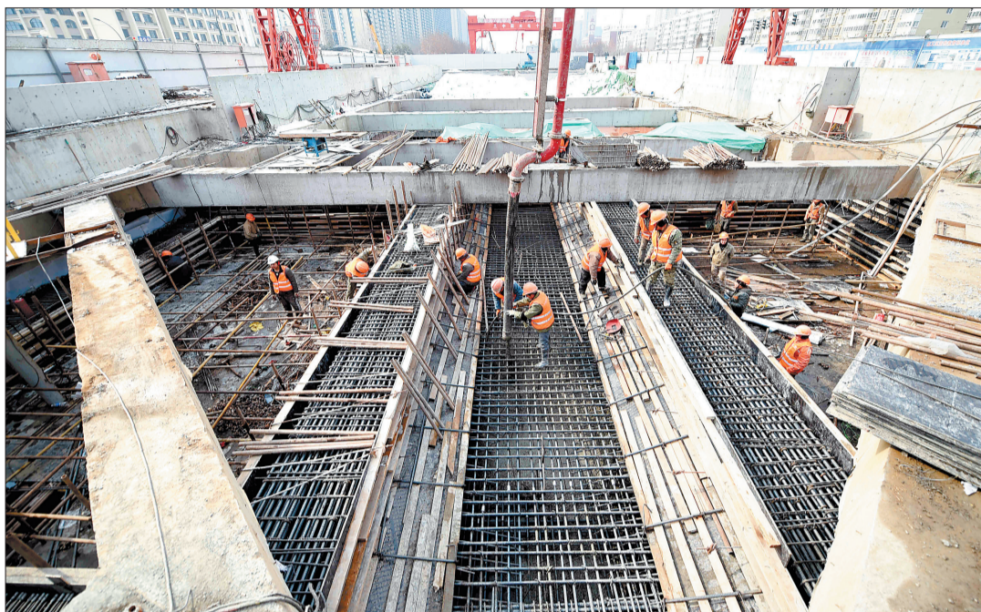
史家湾站施工现场
