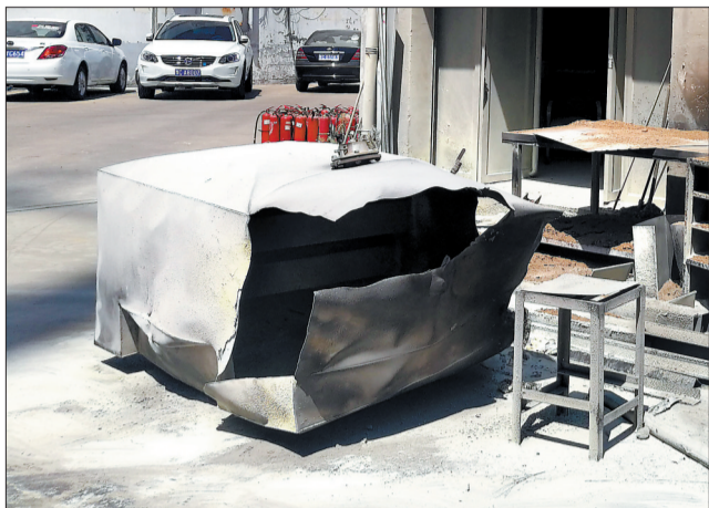
起火的油罐裂开了一个大口子
