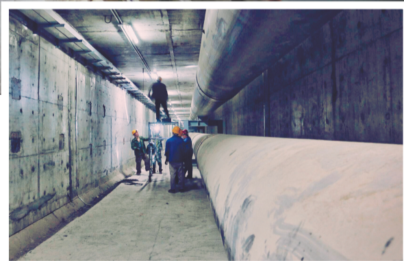
已投用的古城快速路地下综合管廊水舱内景
