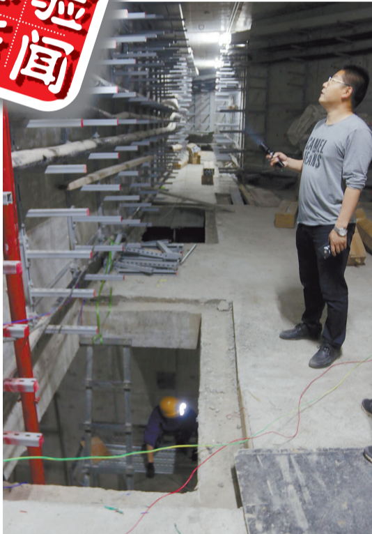
上下两层地下综合管廊在此“立交”
