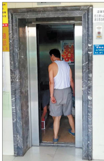
一名业主走进5号楼东边电梯,脚还未完全进去,电梯门已开始关闭
