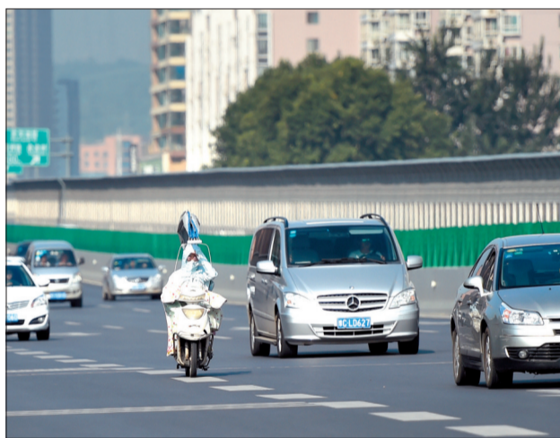
有市民骑车在古城快速路高架桥上行驶
