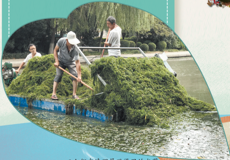
工人们在清理景观渠里的水草
