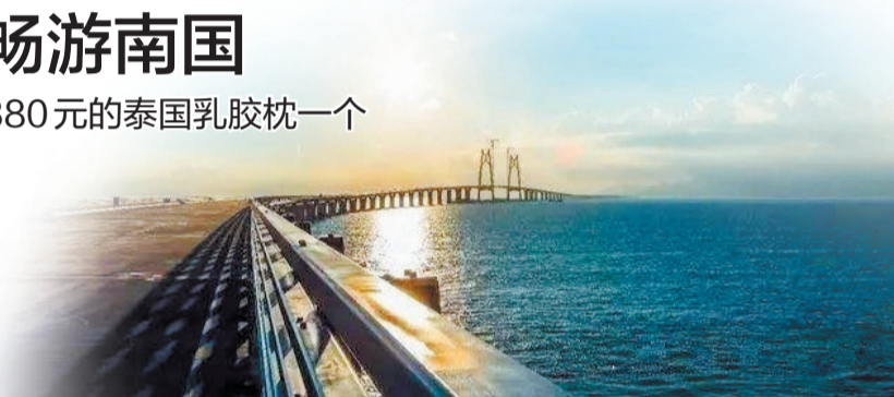
港珠澳大桥(资料图片)
