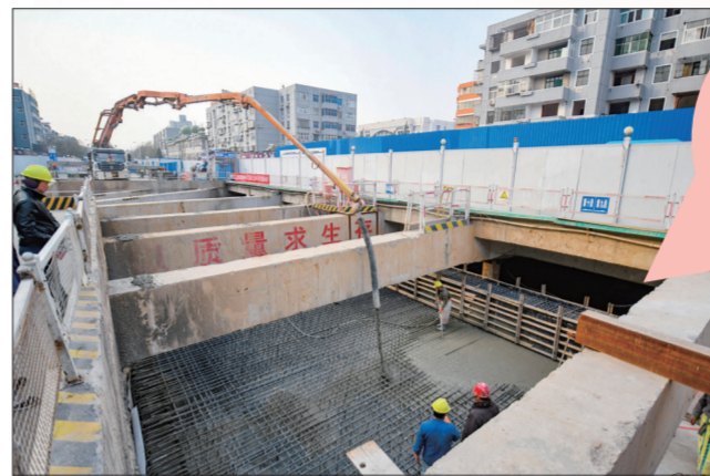
去年,地铁1号线夹马营站实现主体封顶(资料图片)
