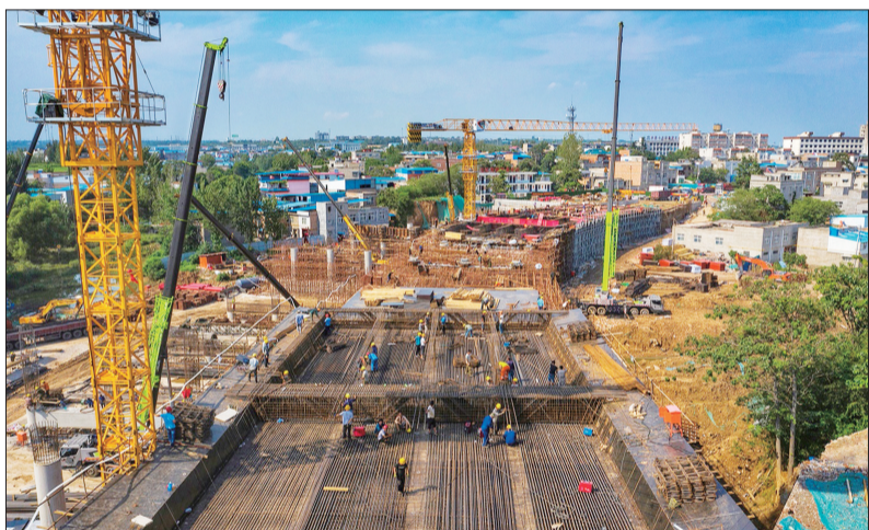
日前，瀍涧大道瀍河大桥施工现场一派忙碌景象 张光辉 摄
