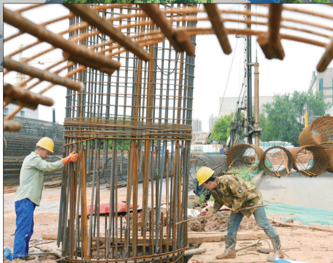
效果图 (资料图片) 工人们向桩基内吊装钢筋笼
