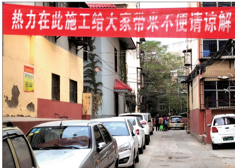
小区内拉出热力施工横幅
