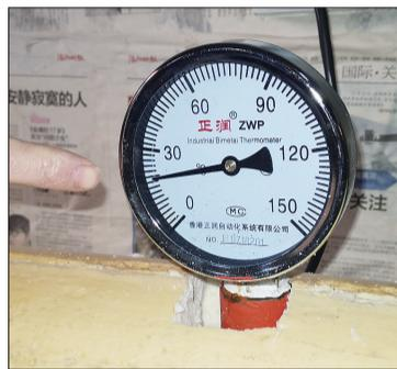
接反的进水管上温度表显示的温度
