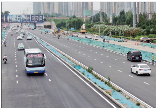
地铁1号线启明南路站以东中州路沿线快车道恢复通行
