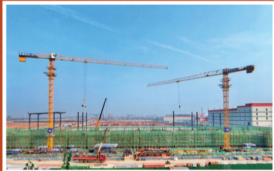
宁德时代洛阳基地二期项目加紧施工
