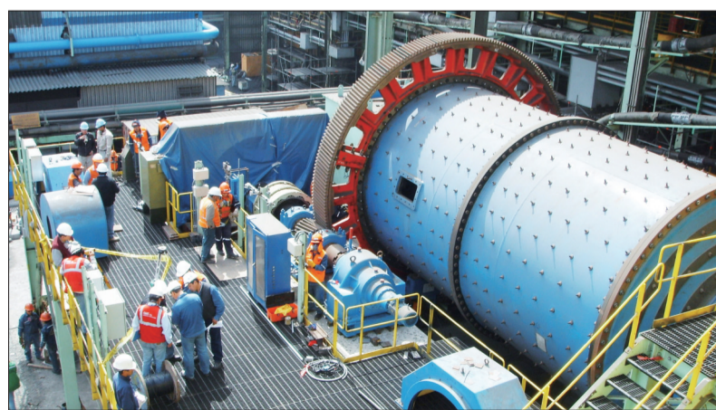
中信重工安装服务人员在秘鲁首钢秘铁项目现场 (资料图片)
