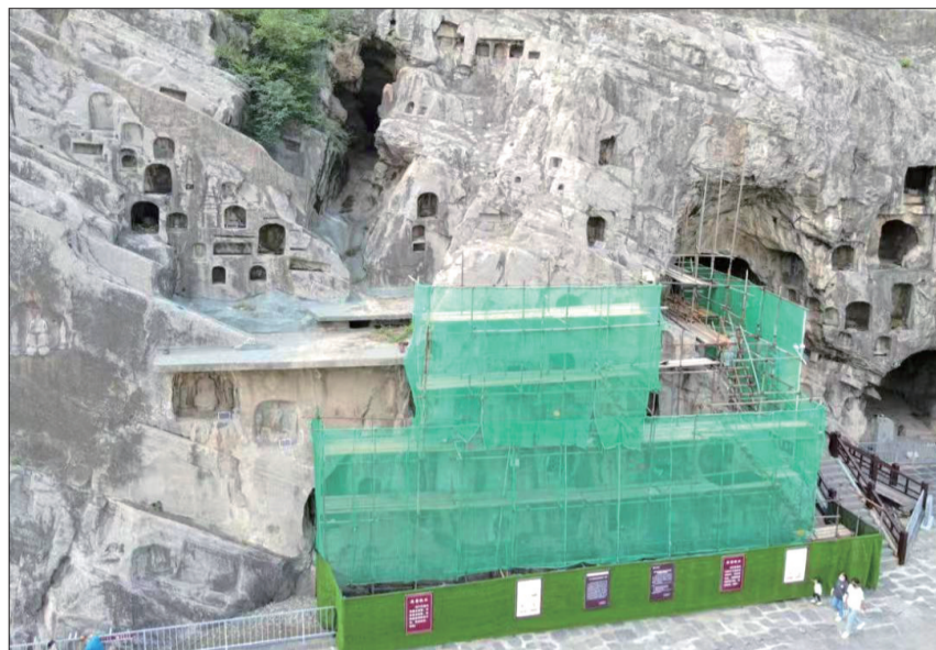
项目施工区域 (图片由王青茹提供)
