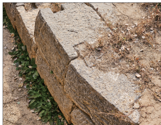
城墙“马面”地基处的大型石块采用榫卯结构连接固定
