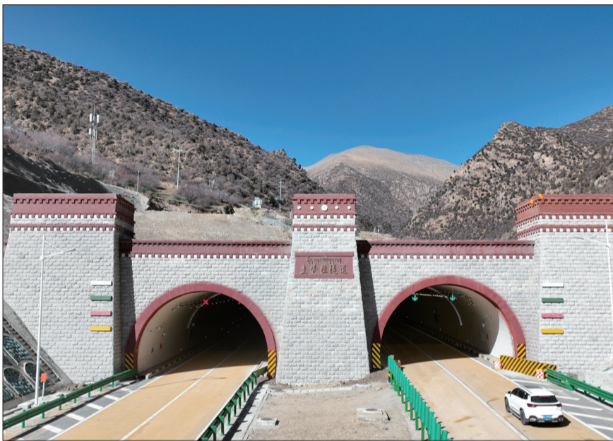
圭嘎拉隧道为分离式双洞四车道公路隧道 (企业供图)
