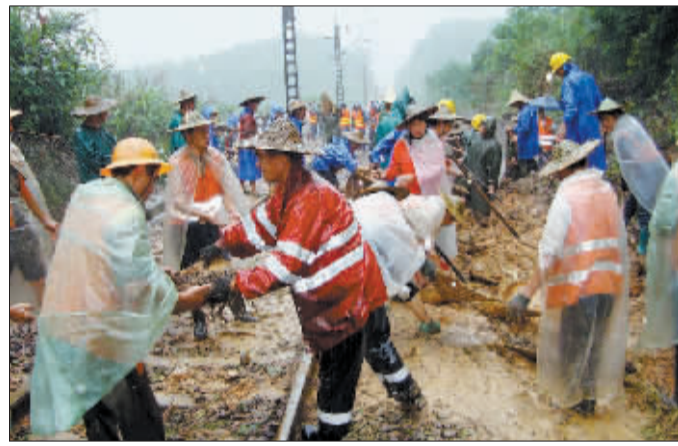
6月19日,抢险人员在江西鹰潭抢修鹰厦铁路水毁路段。(新华社发)
