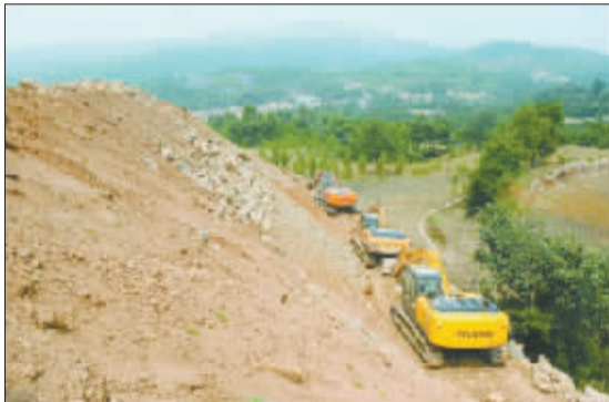
土堆脚下“藏”着3台大型挖掘机。
