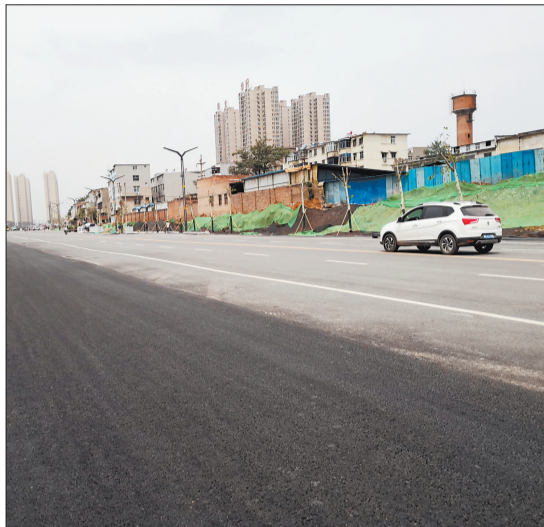
瀍涧大道尚未完工,仅北半幅施划了标线
