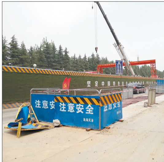
机场西路保通路上有的坑已修复
